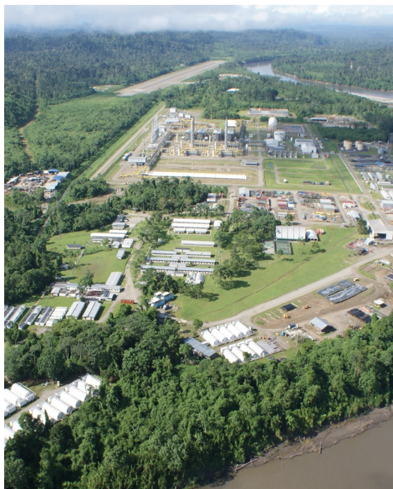
Foto 1. Planta de Procesamiento de Gas Natural, Malvinas.
