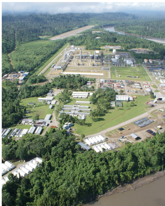
Foto 1. Planta de Procesamiento de Gas Natural, Malvinas.
