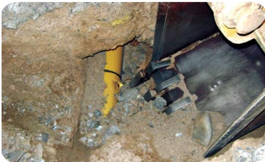
Impacto de la Retroexcavadora sobre el ducto de polietileno
