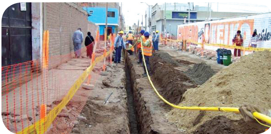
Tendido de tubería en la calle Puno, Proyecto Anillo Vial Central
