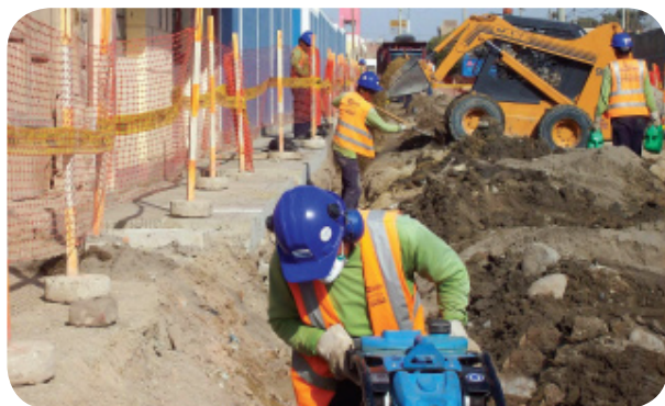
Trabajo de relleno y compactación en la Av. Bolognesi
