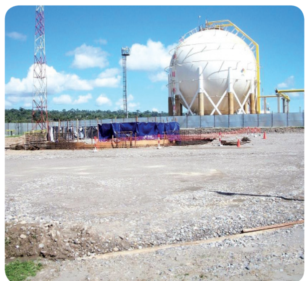
Trabajos en bases de concreto para los nuevos Turbo Compresores - Planta Malvinas
