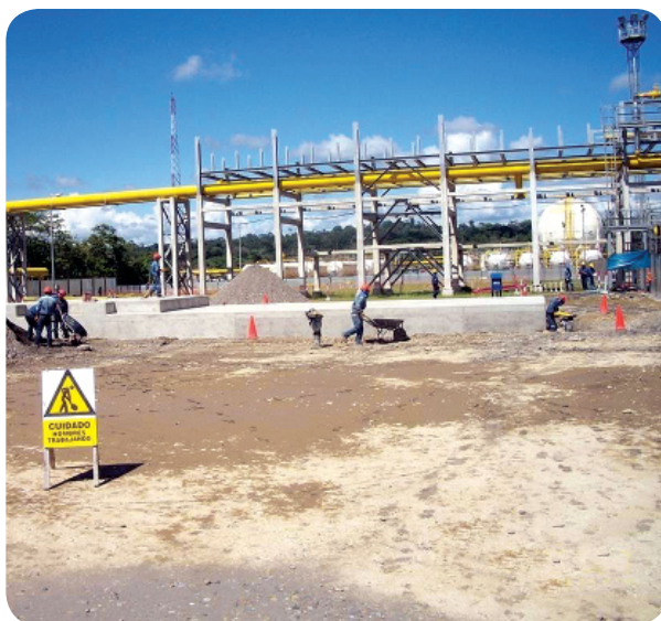
Cimentación de bases donde se instalarán los equipos de procesos - Planta Malvinas
