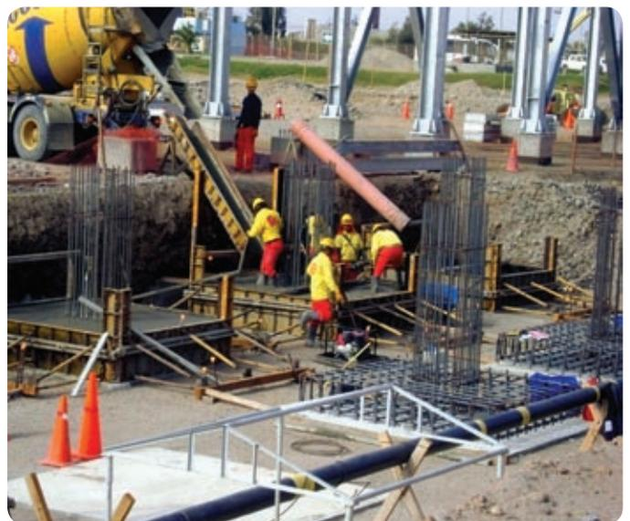
Construcción de bases para aeroenfriadores de las torres fraccionamiento
