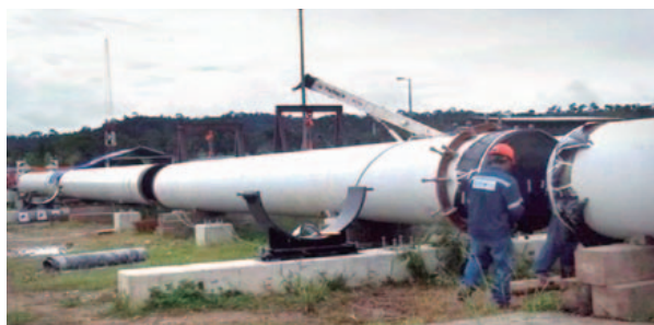
Trabajos de soldadura en el Slug Catcher
