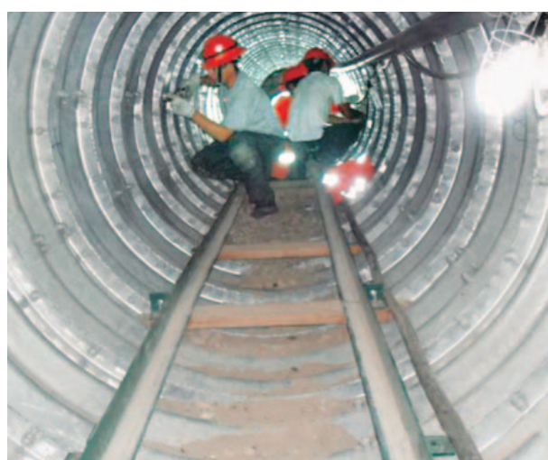
Trabajos en túnel liner en el frente de Ate
