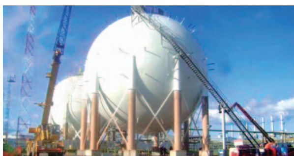
Tanque de Líquidos de Gas Natural (LGN)
