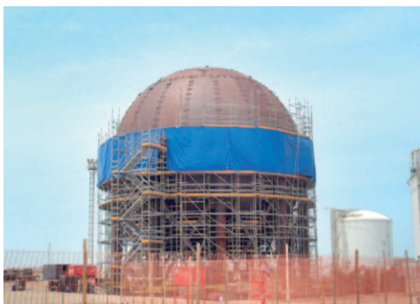
Trabajos de soldadura en el tanque esférico de LGN
