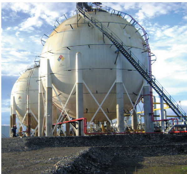
Vista del Tanque Esférico, que cuenta con el sistema de tuberías rociadores de agua contra incendio.
