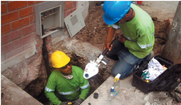
Vista de los trabajos de instalación de tuberías de conexión domiciliarias en Pisco
