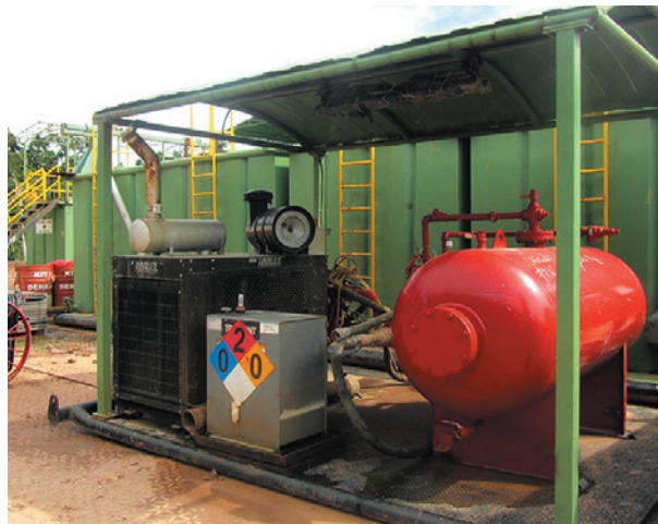
Bomba de Agua Contra Incendio – Locación Sagari
