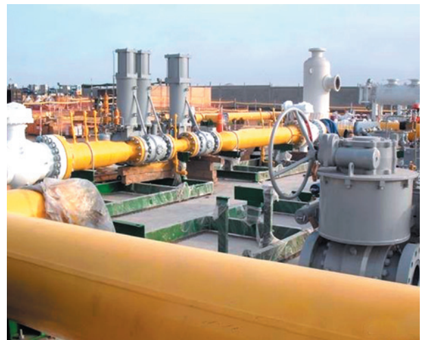
Instalación de equipos en el nuevo City Gate
