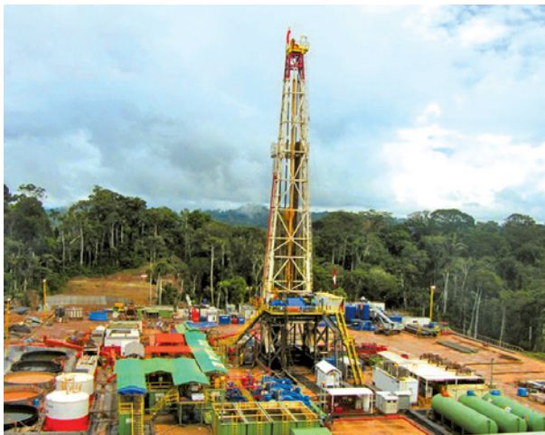
Plataforma de Perforación Izada – Locación Sagari
