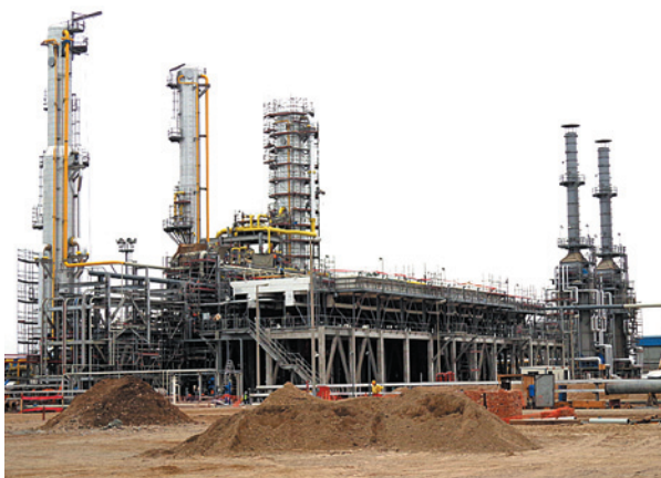
Vista de los trabajos de ampliación de la Planta Pisco
