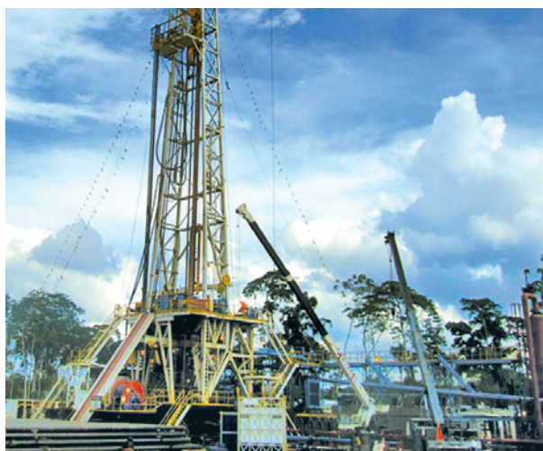
Plataforma de perforación en Pagoreni Oeste
