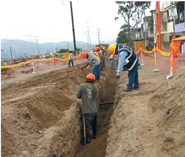
Supervisión de las instalación de tuberías de polietileno en la Av. Pachacutec
