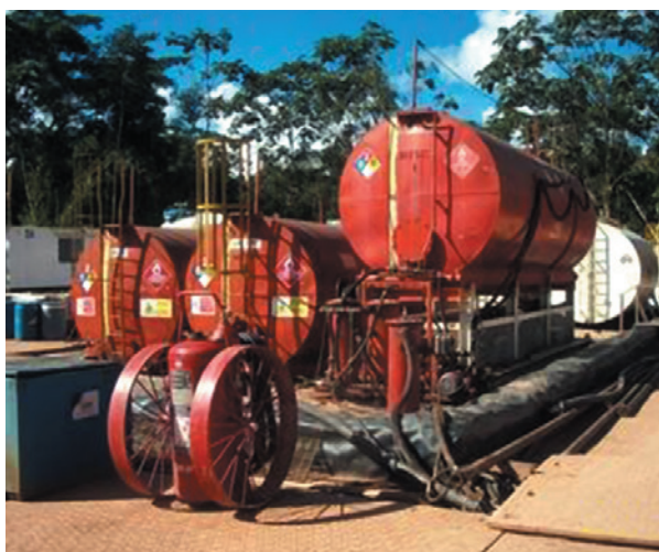
Vista que muestra el almacenamiento de los combustibles usados en la perforación del Pozo Pagoreni OESTE
