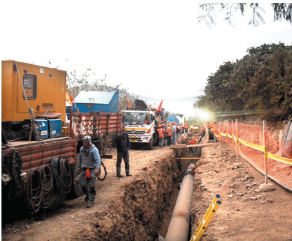
Trabajos de construcción en la zona de San Fernando-Cardal
