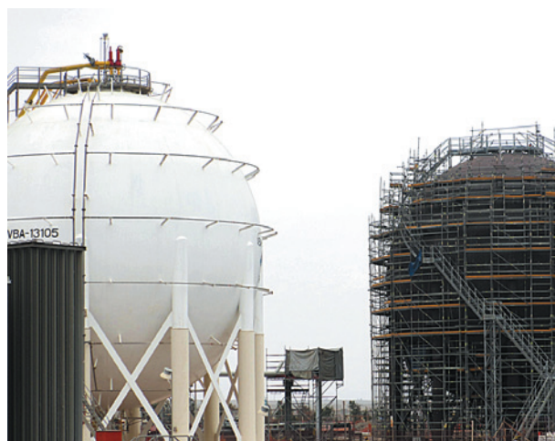
Vista de los trabajos en el Tanque Esférico
