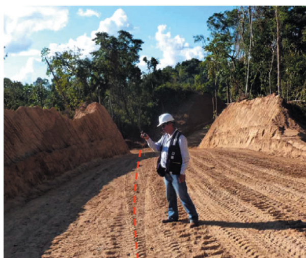
Supervisor de OSINERGMIN en el derecho de vía. La flecha roja indica la dirección del ducto - Flowline Kinteroni – Malvinas
