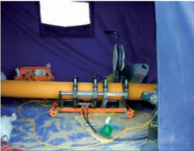
Soldadura de tubos de PE de Ø200 mm por termo fusión, para la troncal de Marcona.
