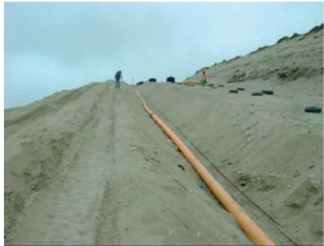
Vista de tubería instalada en zanja junta a cable de fibra óptica en troncal de Marcona de Ø200mm.
