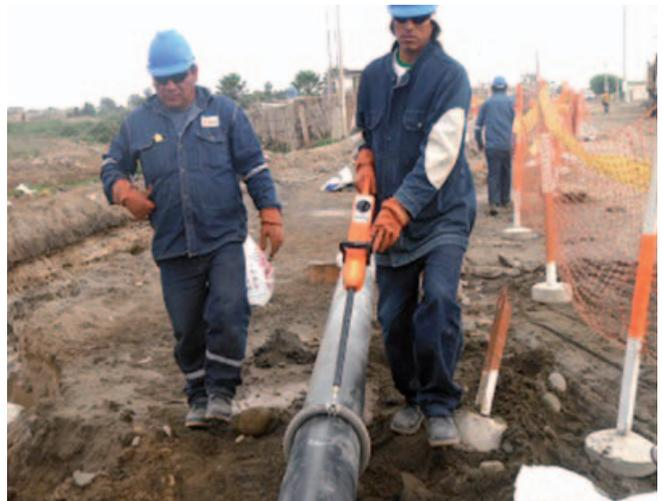
Inspección con equipo Holliday Detector, al revestimiento de Polietileno tri capa de la tubería del gasoducto de Chincha
