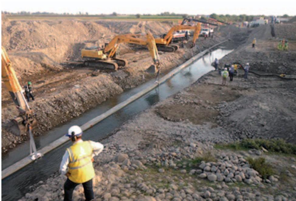
Instalación del ducto de acero de  $\varnothing$  8" con protección mecánica bajo el lecho del río Chíncha.
