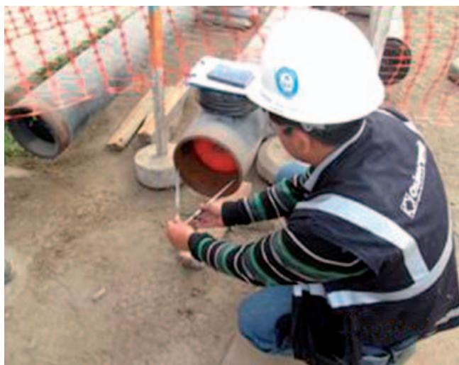
Medición de diámetro interior de la tubería.
