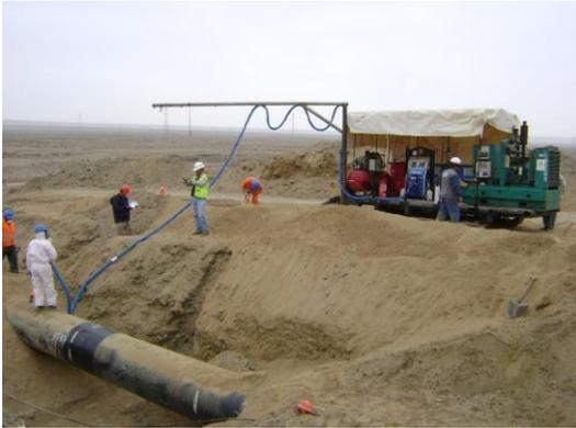
Fig. 10: Equipo de aplicación de espuma (Poliuretano) nótese el empotramiento previo en el terreno antes de la instalación.
