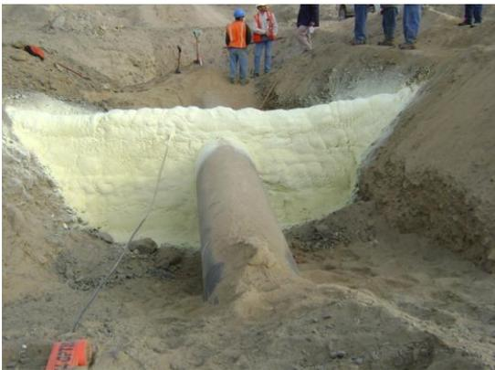
Fig. 11: Barrea en zanja instalada, nótese que el cable de fibra óptica al igual que el ducto esta empotrada en el elemento de retención.
