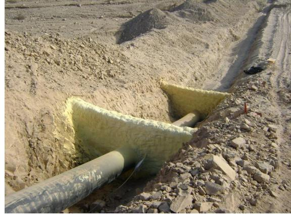
Fig. 3 Tapón en espuma (poliuretano) DDV PERULNG
