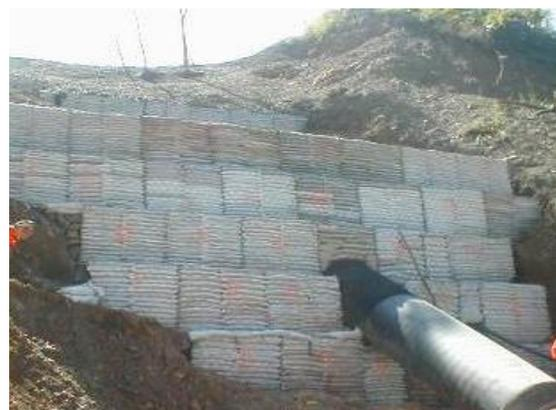
Fig. 4 Tapón en gavión (SSC + Canastilla de gavión)
