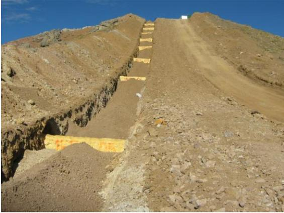
Fig. 1: DDV de PERULNG en el progresiva KP 155, donde se observan barreras de espuma instalados en la zanja y cubiertos por material seleccionado (pre tapado).
