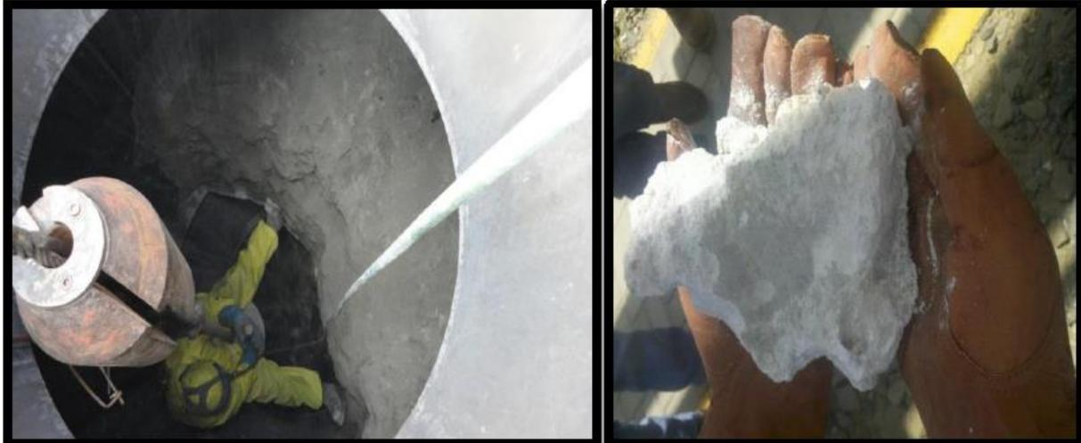
**Figura N° 1.** Representación del estado de tamiz molecular gastado (Presencia de costras)
