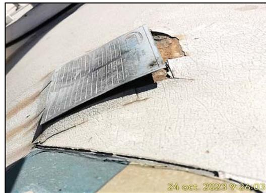
Signos de corrosión bajo la placa de fabricación del tanque estacionario.
