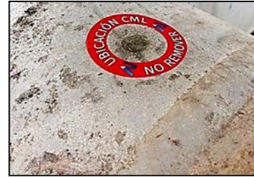
La pintura en el tanque estacionario de GLP se encuentra uniforme y la superficie del tanque no presenta signos de corrosión.
