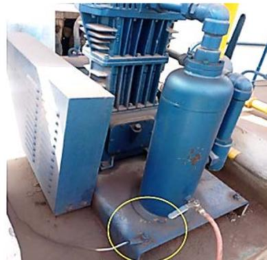
La bomba y el compresor tienen una conexión de puesta a tierra.
