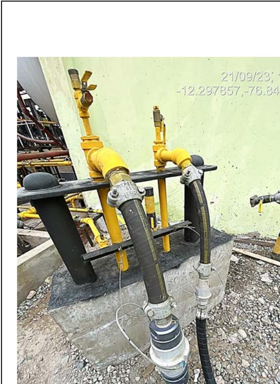
En las mangueras de trasiego de GLP líquido y vapor no se observan daños y fisuras.
