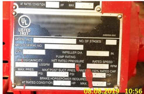
Bomba Contra Incendio. Se muestra detalle de la placa de la bomba y motor
