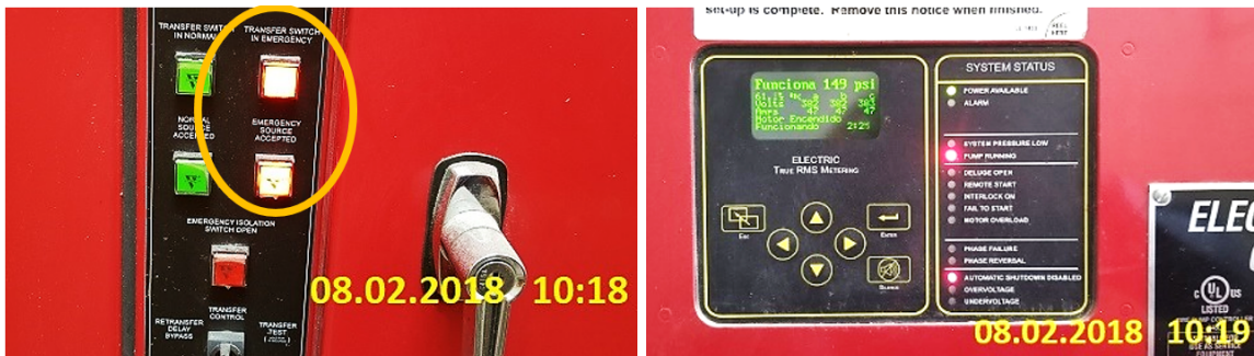
Condición Segura Se encuentra en funcionamiento el motor eléctrico de la bomba contra incendio, mediante el suministro de energía por parte del generador eléctrico.
