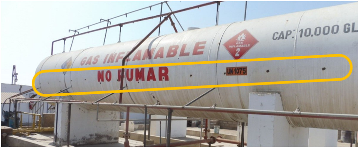
Vista de uno de los lados del tanque estacionario de GLP. Nótese los trabajos de medición de espesores del tanque.
