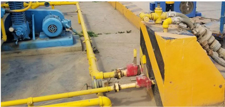
Condición Segura Vista de las válvulas de cierre de emergencia en la zona de carga y descarga de GLP.
