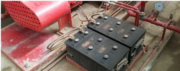
Condición Segura La motobomba cuenta con sus dos (2) baterías.
