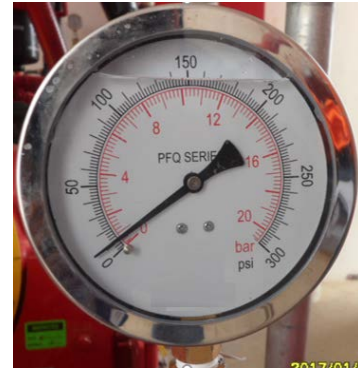
Manómetro en la descarga
