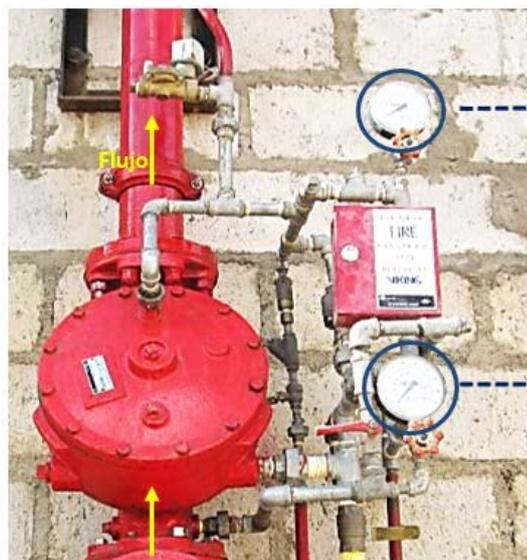
**Manómetro de la Cámara de Diafragma de la Válvula**
