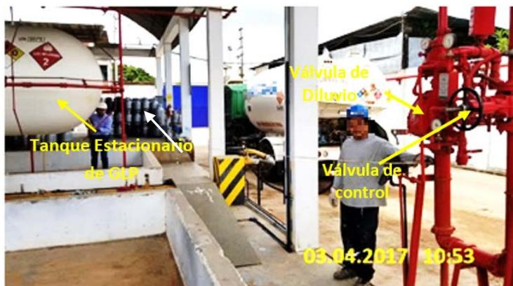
**Instalación Incorrecta de la válvula de control del Sistema Fijo de Aspersión ya que se encuentra muy cerca de una zona con potencial de afectación**
