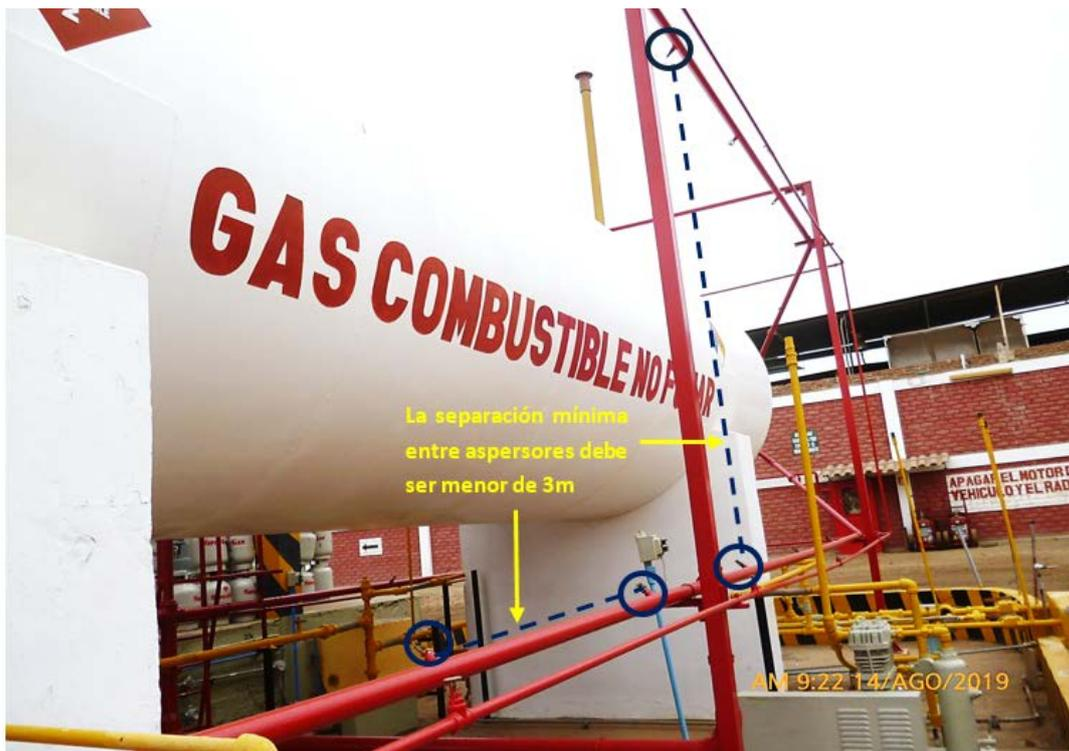
Vista de la ubicación y separación de los aspersores del Sistema Fijo de Aspersión
