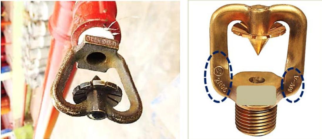
**Vista de la instalación de aspersores con certificación UL y sin pintar**
