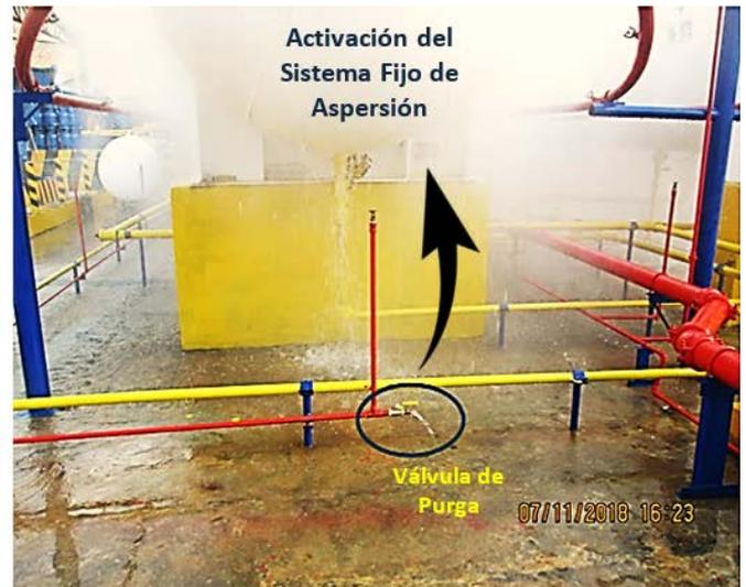
**Válvula de Purga y Activación del Sistema Fijo de Aspersión**
