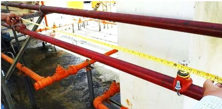
**En la imagen se observa que se está realizando la verificación de la distancia horizontal de rociadores piloto.**
