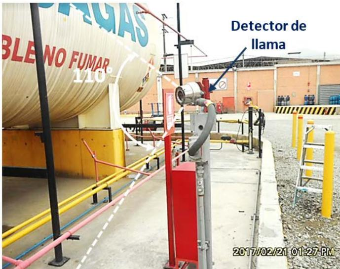
En la imagen se puede observar un detector de llama infrarrojo, con un cono de visión de 110° y un rango de detección mayor a 60m
