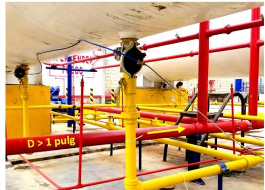
**Vista de las tuberías del Sistema de Aspersión debidamente pintadas**
