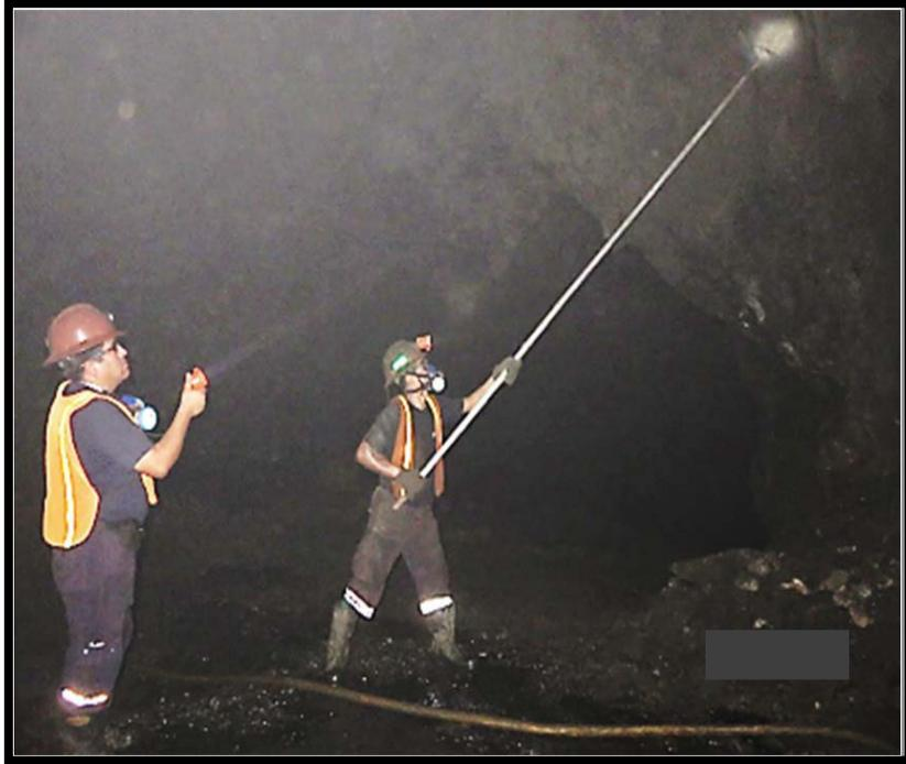
Desate de rocas manual utilizando barretillas.
