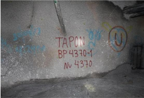
*Labor abandonada gaseada y paralizada definitivamente con tapón hermético recubierto con shotcrete*
