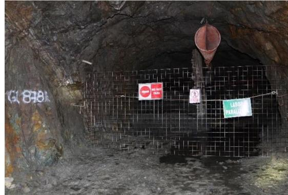
*Labor paralizada temporalmente con tapón de malla electrosoldada*
