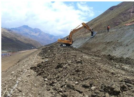
Consiste en la colocación de un contrapeso en la base de la superficie del talud aguas abajo de la presa, para contener eventuales deslizamientos.
