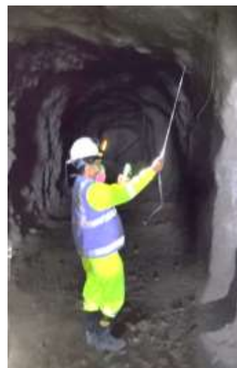
Medición de la velocidad de aire con el instrumento anemómetro con sonda de hilo caliente. Fuente: Osinergmin
