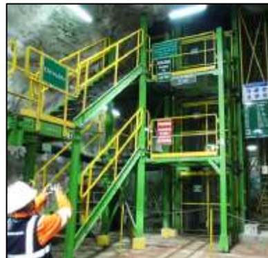
Estación del pique, donde se evidencia el compartimiento de la jaula, con puerta metálica que restringe el acceso.
