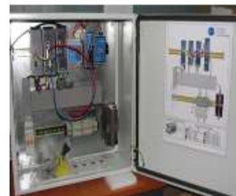
Componentes de una Estación Microsísmica
