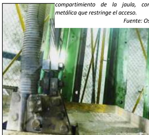
Amarre y unión entre la jaula y el cable tractor, parte superior de la jaula, mediante un componente de acero estructural asegurado con pines, abrazaderas sólidas y pernos.
