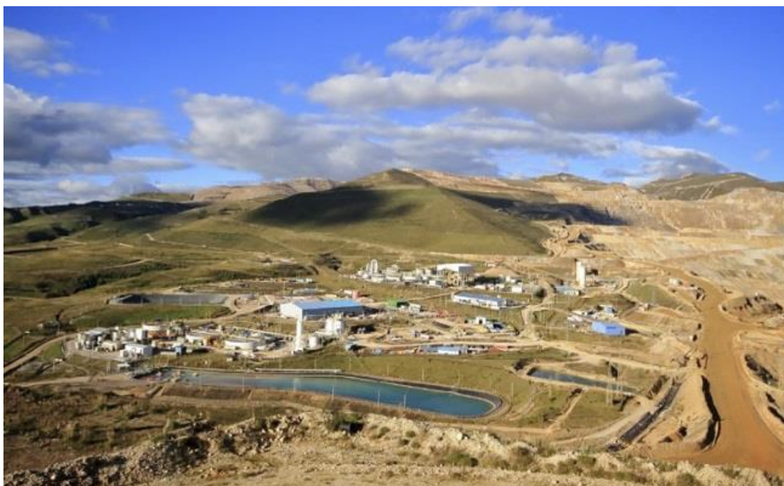
Yanacocha, fuente: Rumbo Minero
