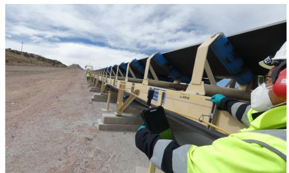
Verificación de la falta de guardas de protección en la faja transportadora CV-201 de transporte de mineral de chancado primario, en los polines de carga y retorno en ambos lados (Fuente: Fiscalización en Plantas de Beneficio, Junio 2021)
