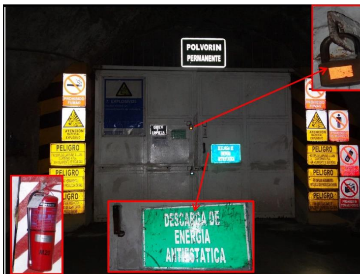
Puerta de ingreso al polvorín permanente del Nv3189, UM Catalina Huanca Fuente: Osinergmin
