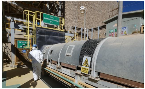
Faja transportadora con guardas de protección y cable interruptor de emergencia (Fuente: Fiscalización en Plantas de Beneficio, Julio 2021)
