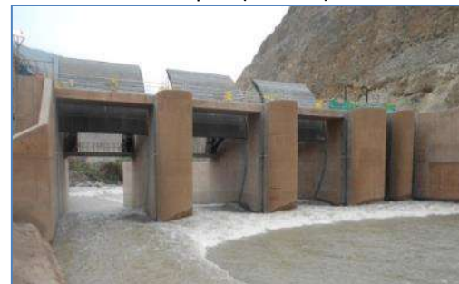
Presa Picunche- barraje móvil
