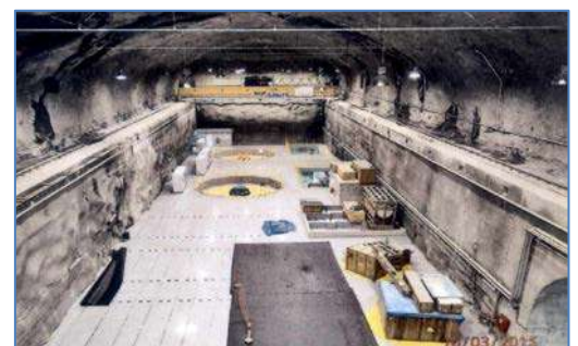
Vista de la Casa de Máquinas
