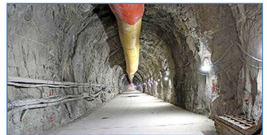
Túnel de Descarga
