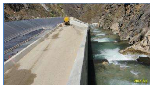
Reservorio de Regulación Diaria (Sector Shapiringo)
