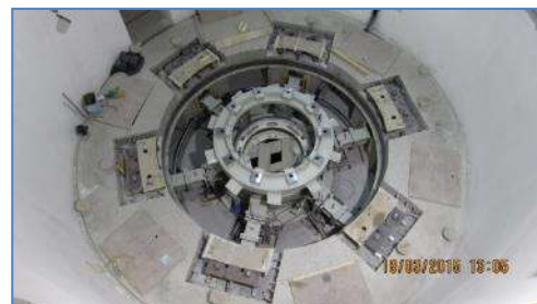
Trabajos previos al montaje del Generador N° 2
