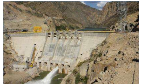
Vista posterior de la Presa
