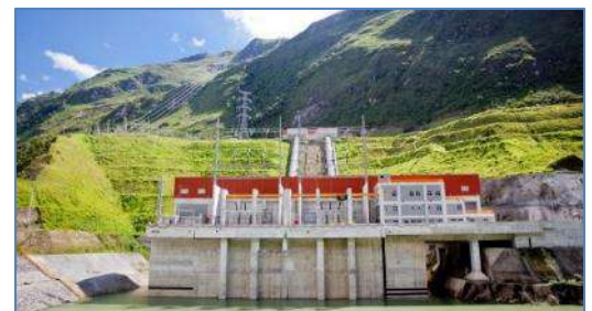
Casa de Máquinas principal
