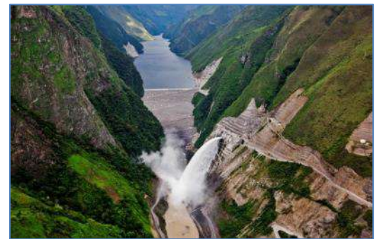
Vista general de la presa
