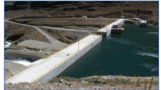
Presa Pallca y la Bocatoma
