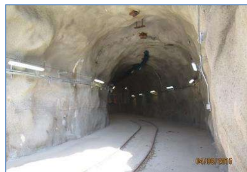
Túnel de acceso a la Cámara de Carga
