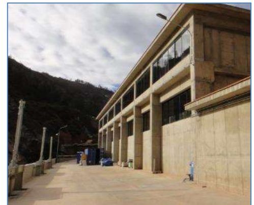
Casa de Máquinas
