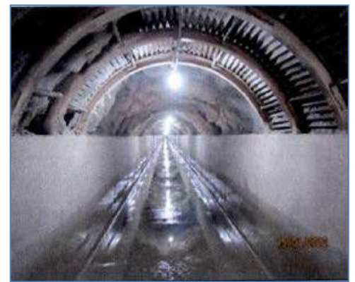
Túnel Huasahuasi I
