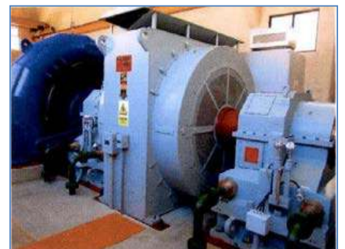
Grupo de Generación (Turbina Hidráulica-Generador Eléctrico)
