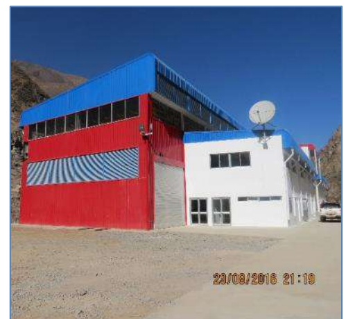
Vista de la Casa de Máquinas
