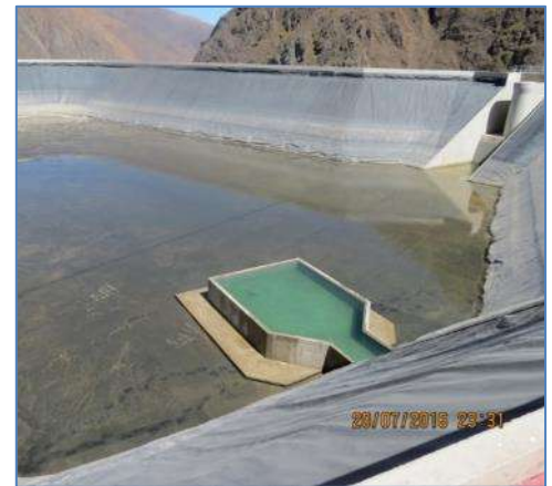
Reservorio de regulación Rapacán
