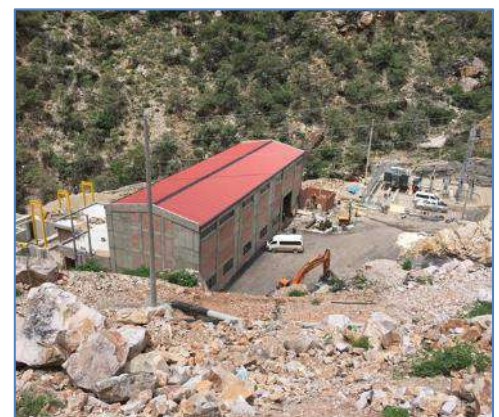
Vista panorámica de la Casa de Máquinas y Subestación
