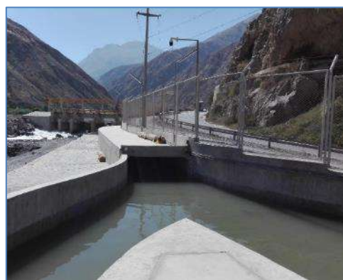
Bocatoma y Canal de Conducción
