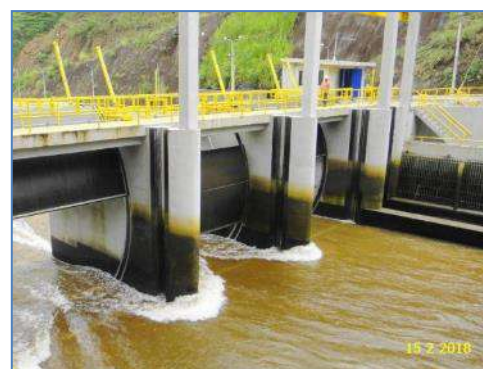
Bocatoma y sus compuertas radiales
