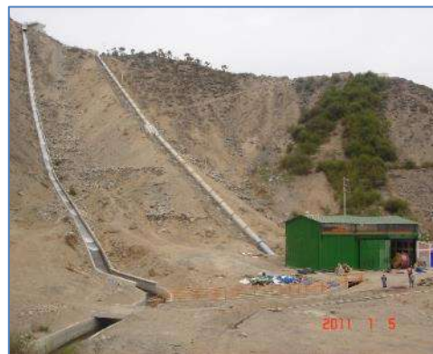
Casa de Máquinas
