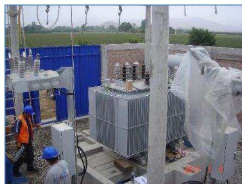
Instalación de Transformador de Potencia
