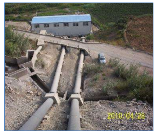
Casa de Máquinas
