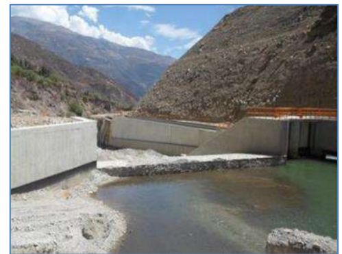
Bocatoma, Desarenador y Canal de Aducción
