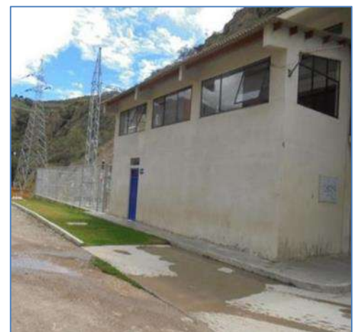
Casa de Máquinas
