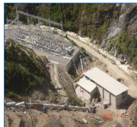
Casa de Máquinas y Tubería Forzada
