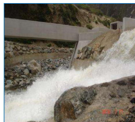
Puente Canal Huasahuasi II
