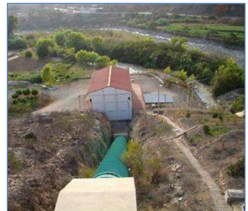
Tubería de Presión
