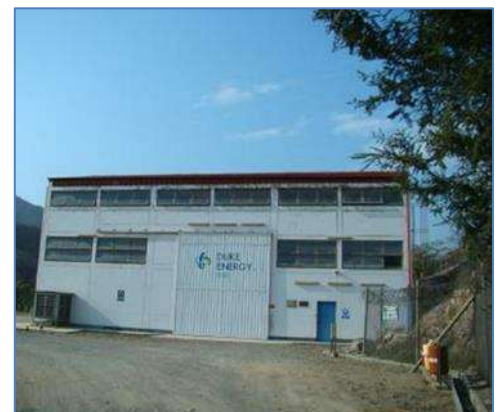
Casa de Máquinas
