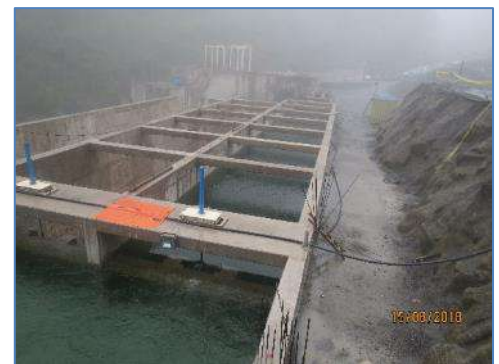
Desarenador – Compuertas de salida
