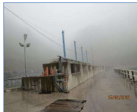
Cilindros hidráulicos de toma secundaria
