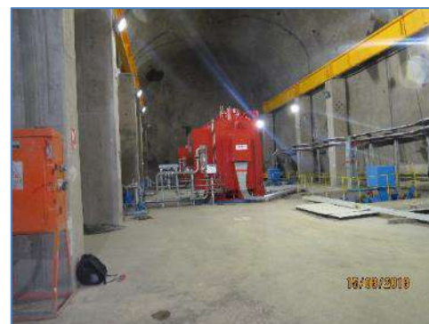
Casa de máquinas concluida
