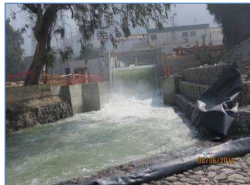
Vertedero del Canal de Descarga
