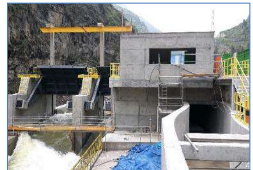
Barraje de Bocatoma y Sala de Control
