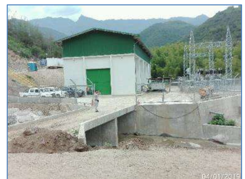
Casa de Máquinas
