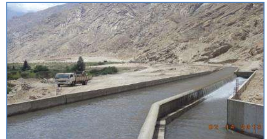
Canal de Conducción Concluido
