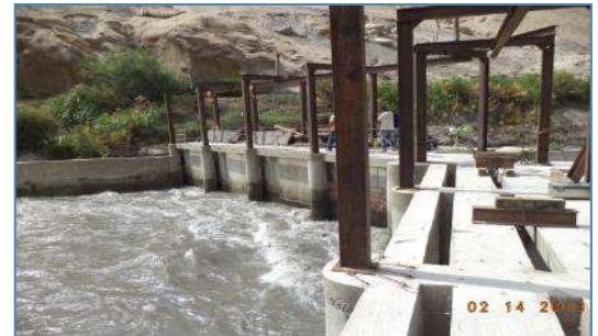
Obra de Captación
