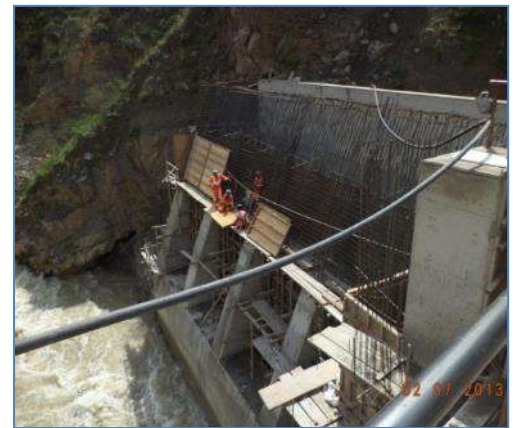
Vista Panorámica Captación, Ataguía
