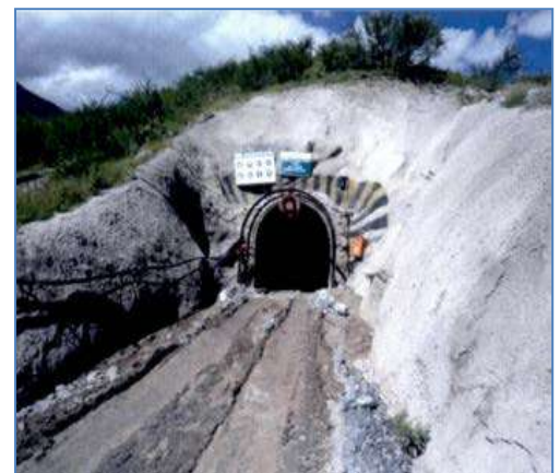
Túnel Principal Portal Salida, Tubería Baja Presión
