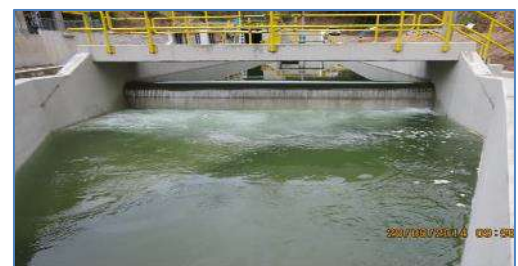
Vista del canal de conducción
