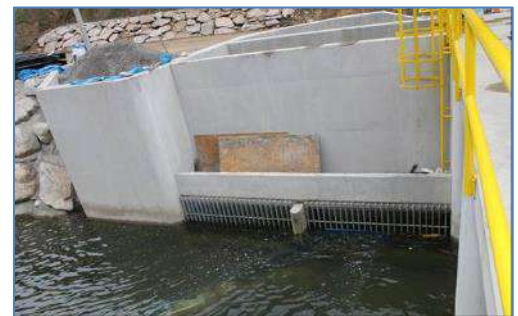
Ventana de captación
