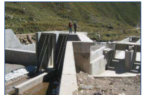
Vista panorámica Bocatoma
