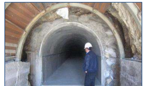
Vista del Túnel
