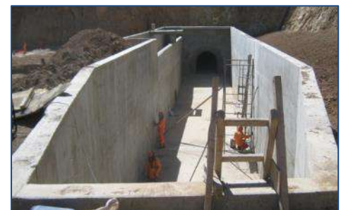
Acabados en la Cámara de Carga
