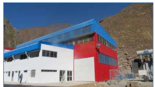
Casa de Máquinas C.H. Chancay y C.H. Rucuy
