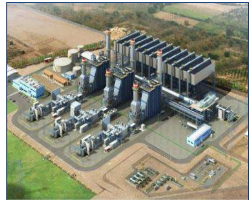
Vista General de la central
