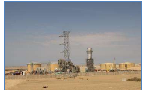
Vista panorámica de la central
